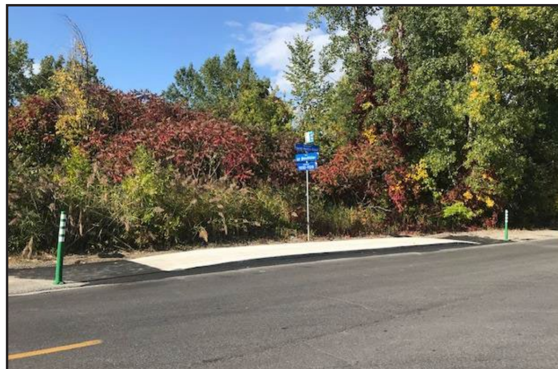
Projet pilote de plateformes surélevées pour les arrêts sans trottoir ni bordure.
