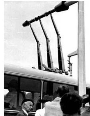
Figure 15, perches d'alimentations du Gyrobus
